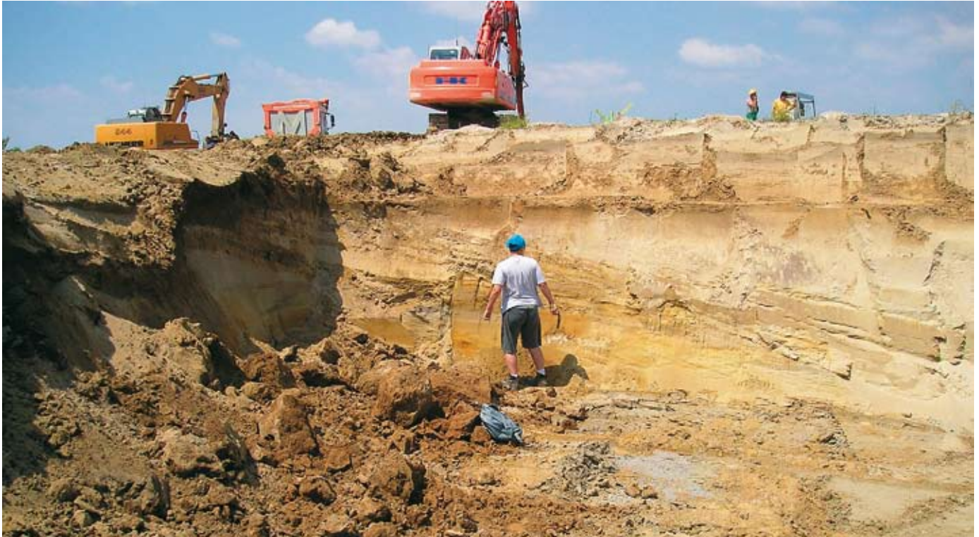
Fig. 3.6. Rilievo di una sezione stratigrafica affiorante su una parete di scavo nei cantieri del Passante di Mestre (foto Abbà T., Provincia di Venezia, 2006).
