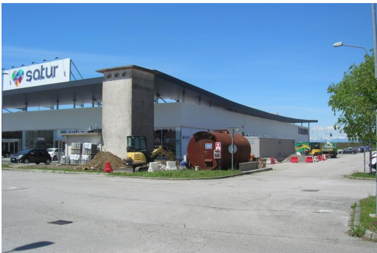
Foto 3 - veduta del nuovo edificio commerciale da via Como, angolo sud-ovest. Al centro della foto è ancora visibile la cabina elettrica obsoleta della quale è prevista la sostituzione e spostamento.
