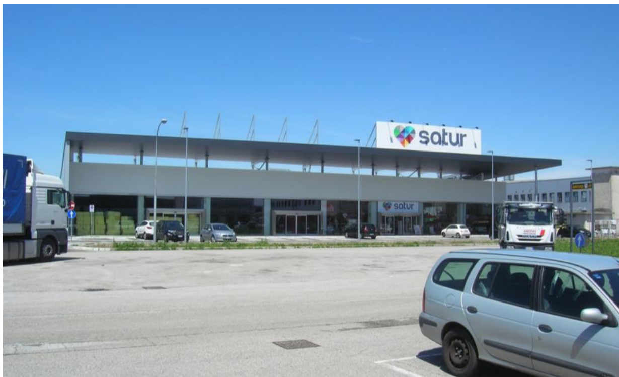
Foto 4 - veduta del nuovo edificio commerciale da via Como da sud.
