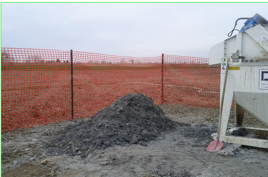
**Figura 36 – Esempio di materiale sabbioso in uscita dal vibrovaglio.**
