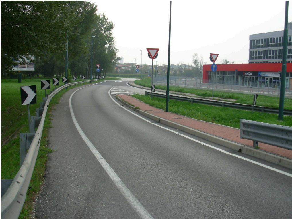
Foto n. 6 – Strada Regionale n. 245 (direzione est)
