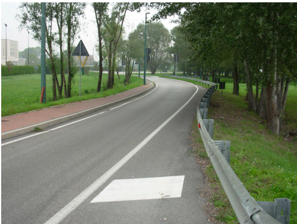
Foto n. 7 – Strada Regionale n. 245 (direzione ovest)
