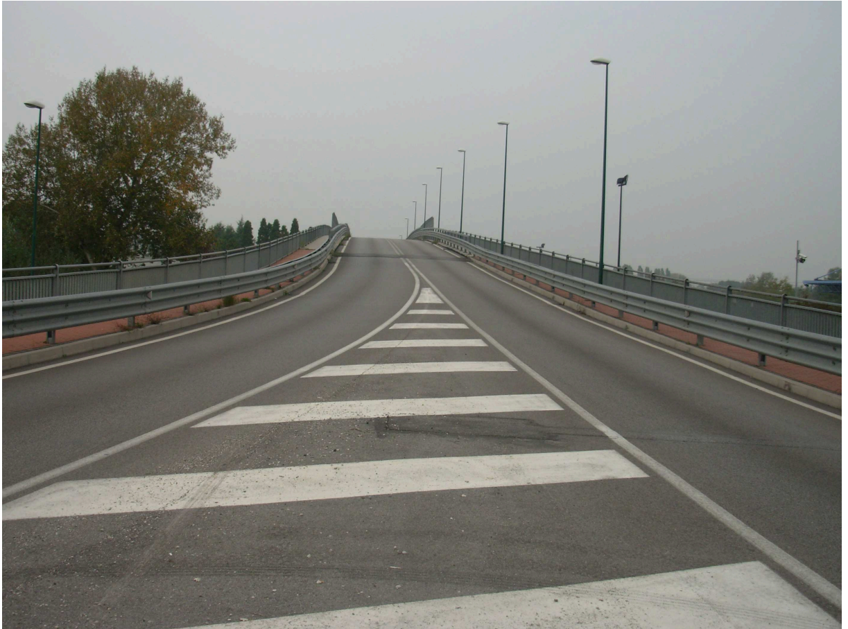
Foto n. 5 – Via Gianquinto/Strada Regionale n. 245 (cavalcaferrovia)
