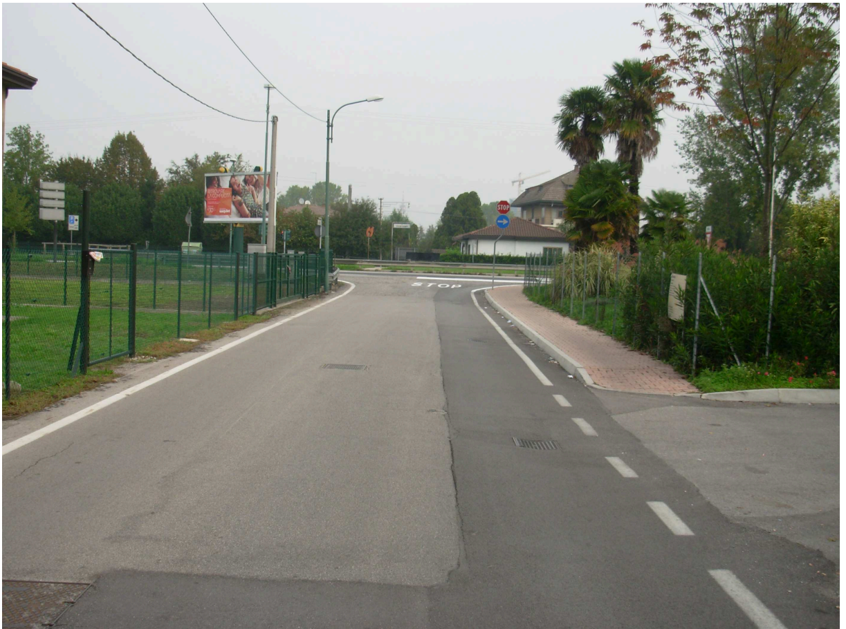
Foto n. 8 – Via del Gazzato
