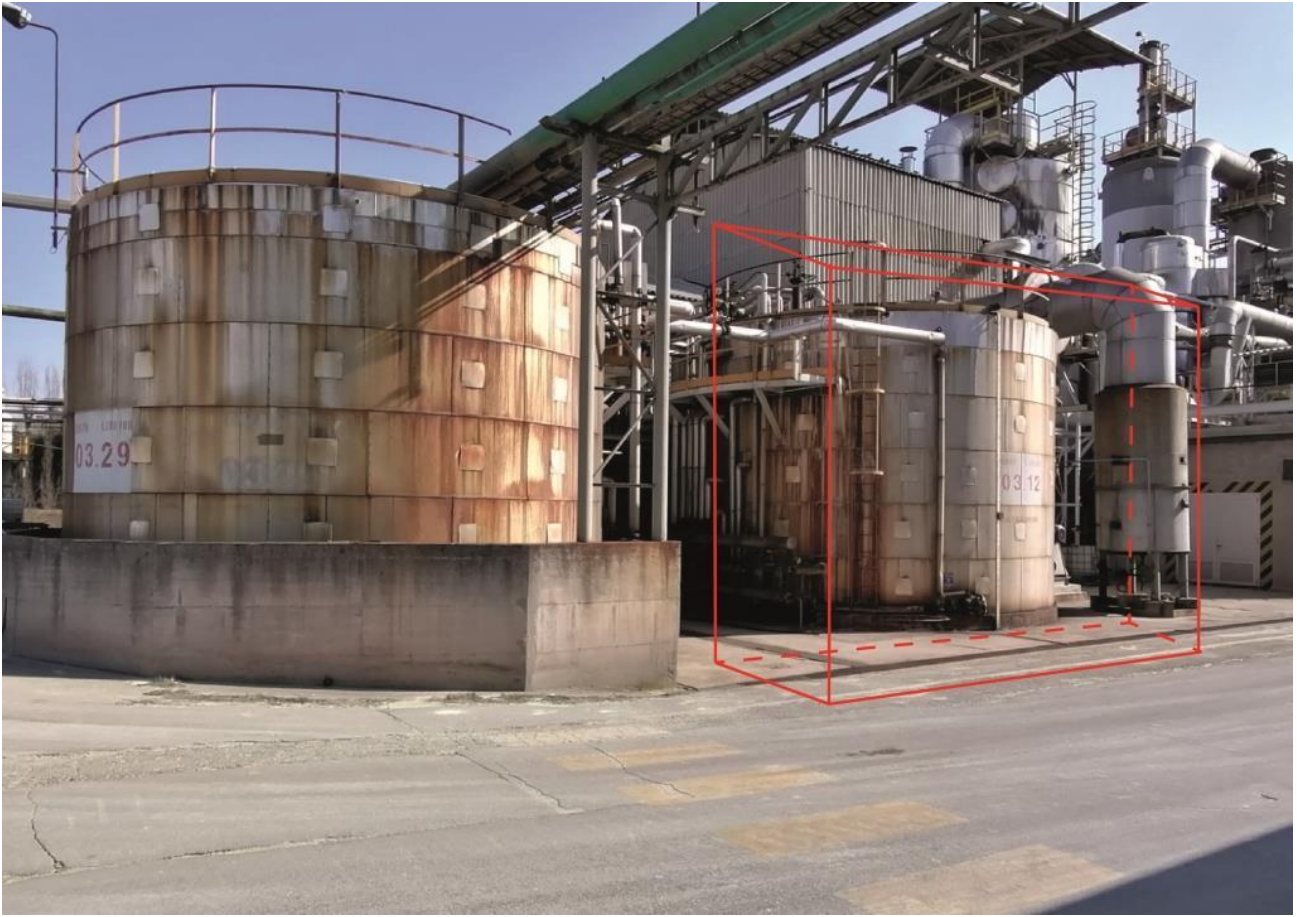
Fig. 10 - Nuova baia di carico (vista da Sud)
