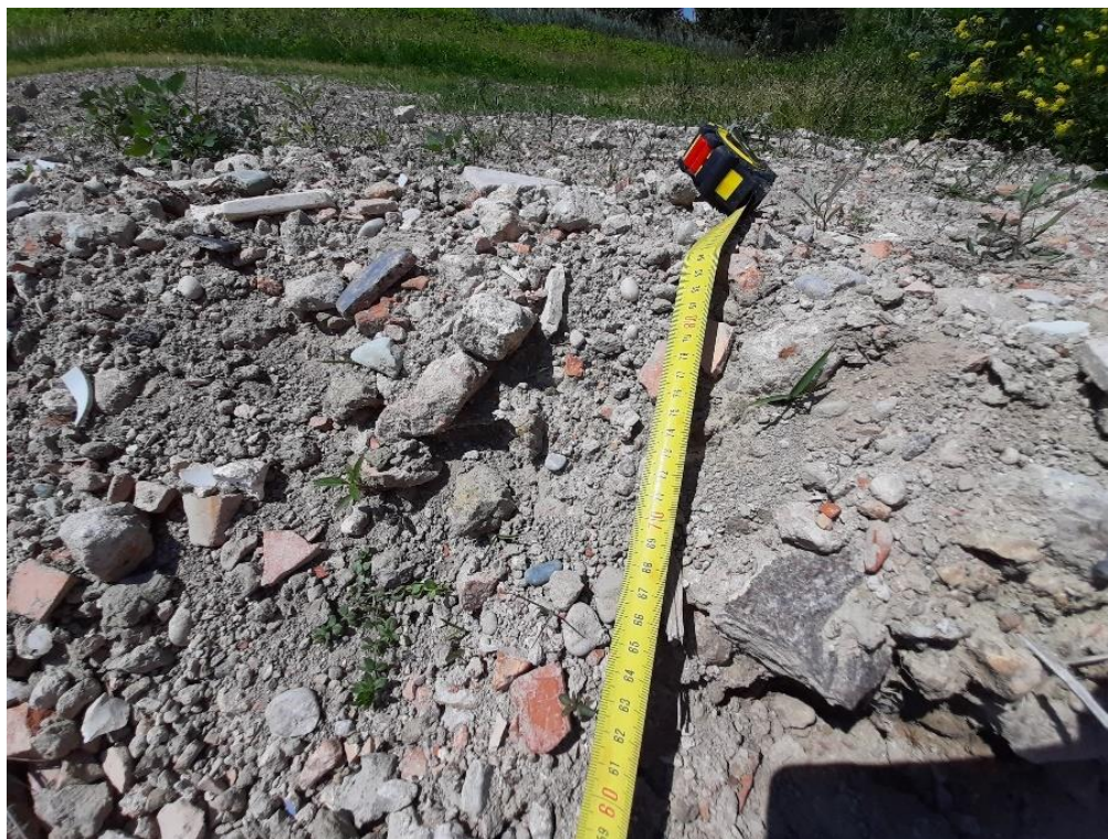
Figura 9: Scavo numero 1. Profondità inerte c.a. 80 cm
