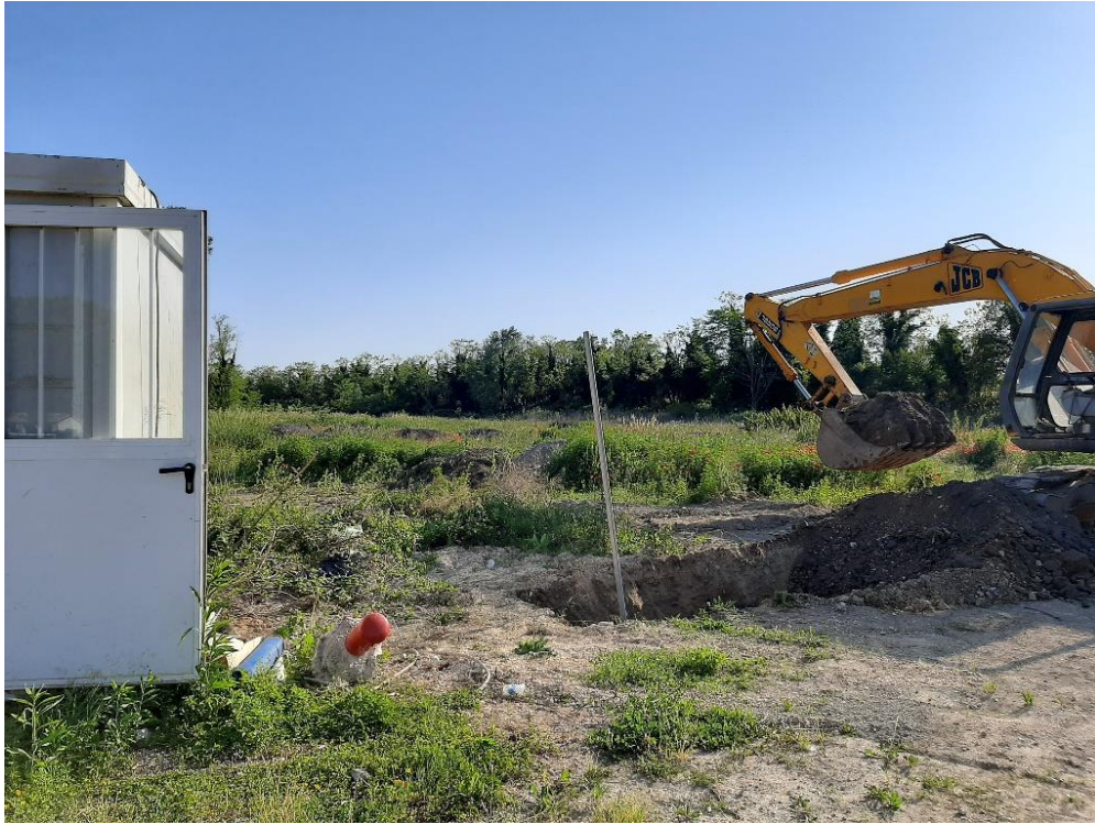
Figura 12: Scavo numero 3. Profondità materiale inerte 30 cm
