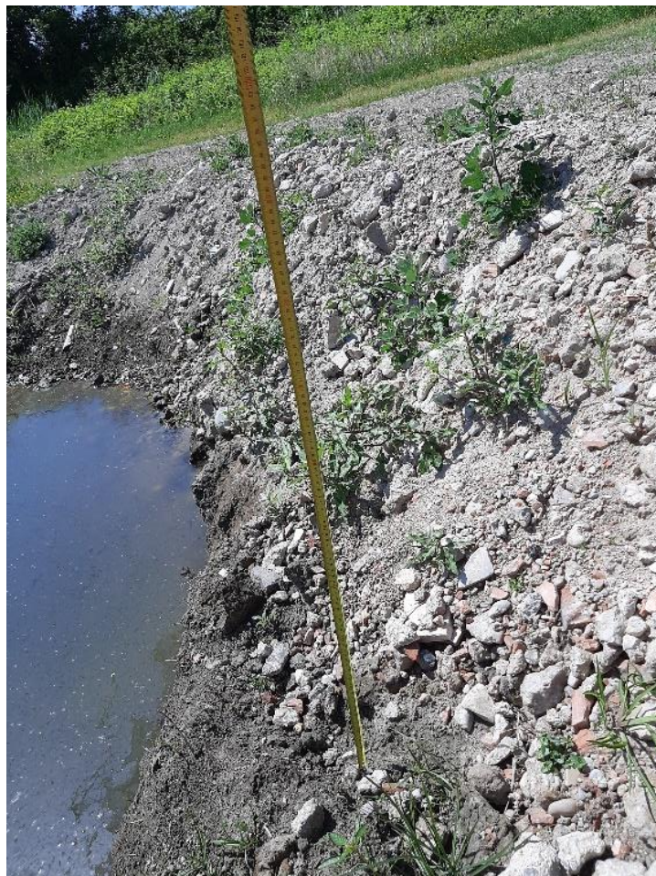
Figura 8: Scavo numero 1. Profondità inerte c.a. 80 cm
