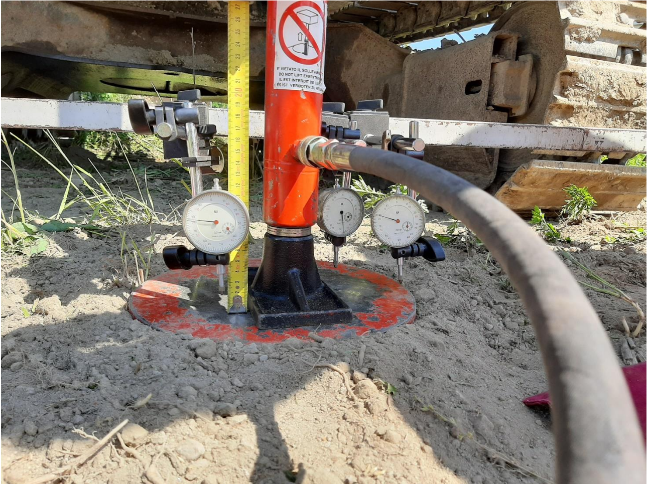
Dopo il carico
