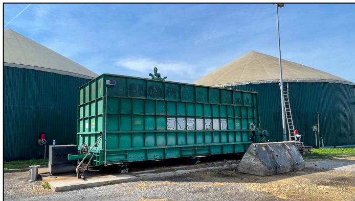
Fotografia della tramoggia di carico degli insilati già installata e attiva sull'impianto esistente L0
