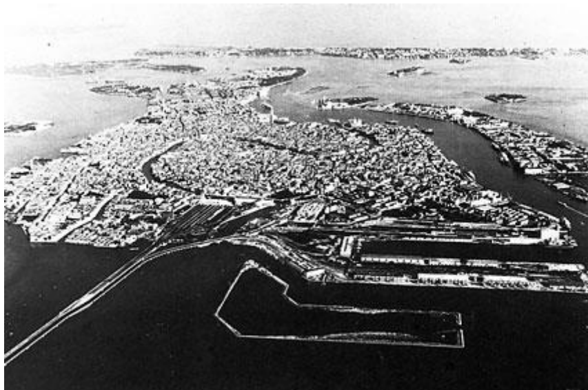
Figura 4.44. Lavori di arginatura e colmataura dello specchio d'acqua lagunare per la realizzazione dell'isola del Tronchetto (Fonte: www.intercostruzioni.eu )
