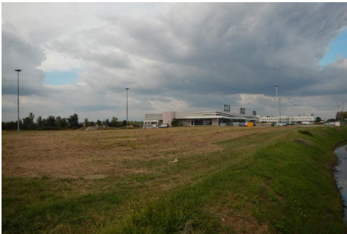
FOTO 4: vista dall'angolo sud-est del lotto e del corso d'acqua vincolato e foto inserimento dell'edificio in progetto
