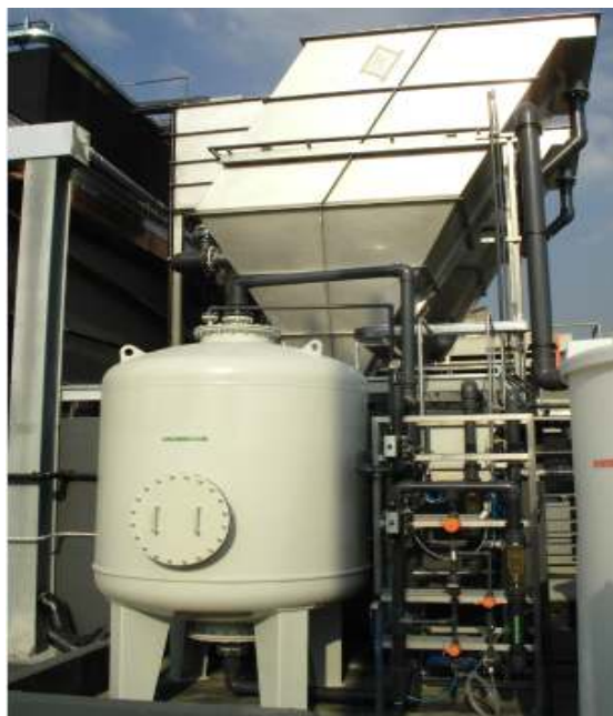
Esempi di filtrazione a quarzite
