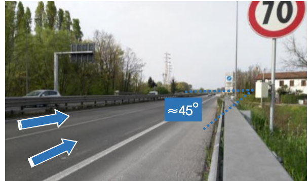
Figura 25 – Angolo di installazione dei radar rispetto alla direzione di marcia
