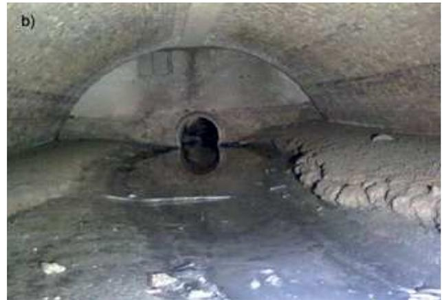
Fig. 18.15 - Criticità idrauliche: due esempi di riduzione della sezione di un canale.
