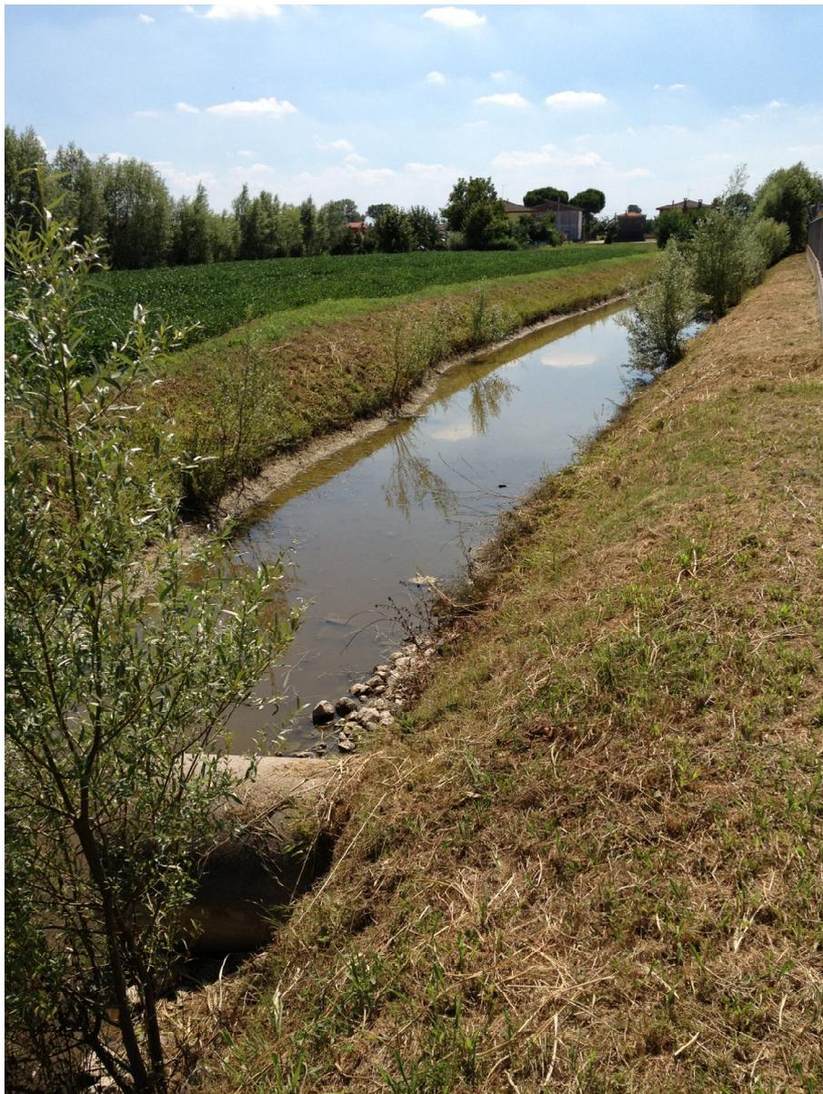
*Figura 2.4 – Il fosso di invaso realizzato ad est della lottizzazione (in base allo studio idraulico del 2002)*
