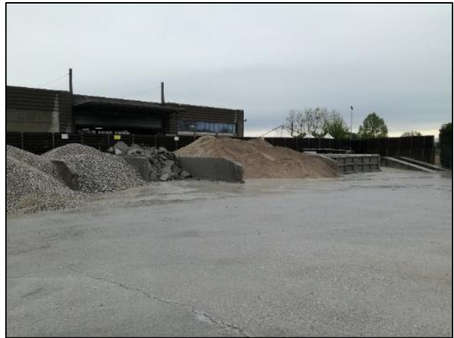
Fig. 4: Vista piazzale e deposito materie prime inerti
