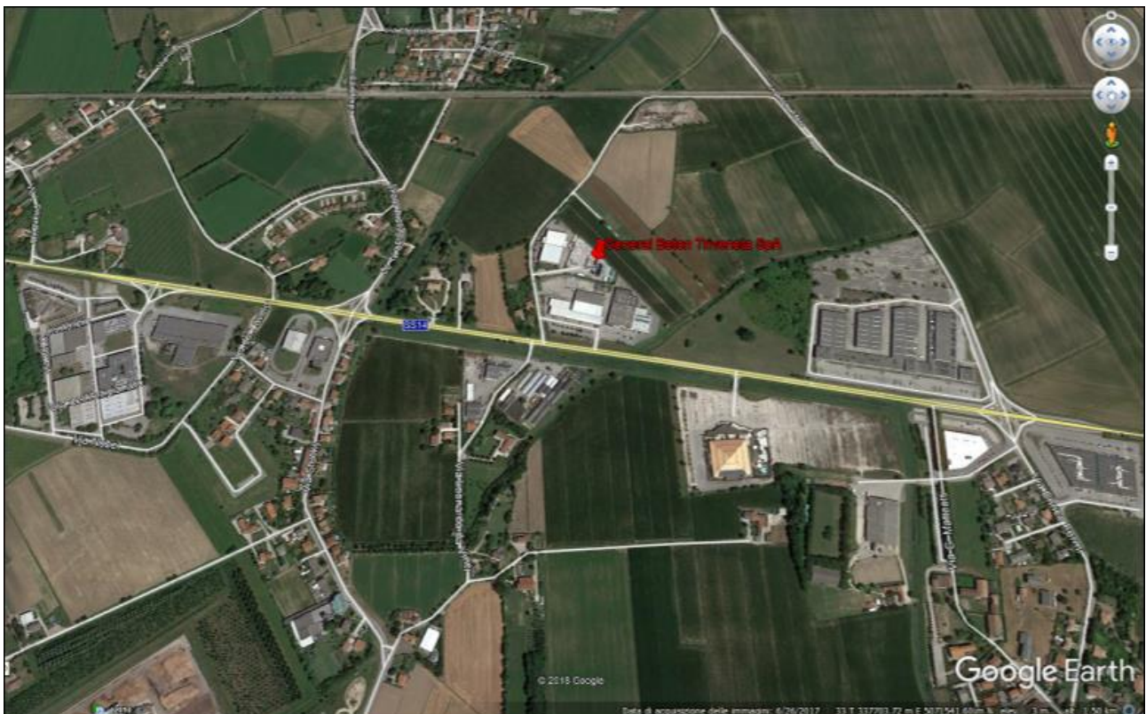
Fig. 12 - Foto aerea della zona industriale di Fossalta di Portogruaro (Google Earth 26/06/2017)
