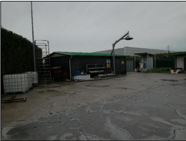
Fig. 3: Polistirolo: deposito e impianto dosaggio
