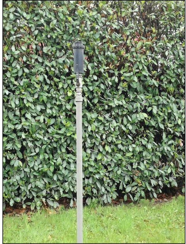
Fig. 8: Impianto bagnatura piazzale
