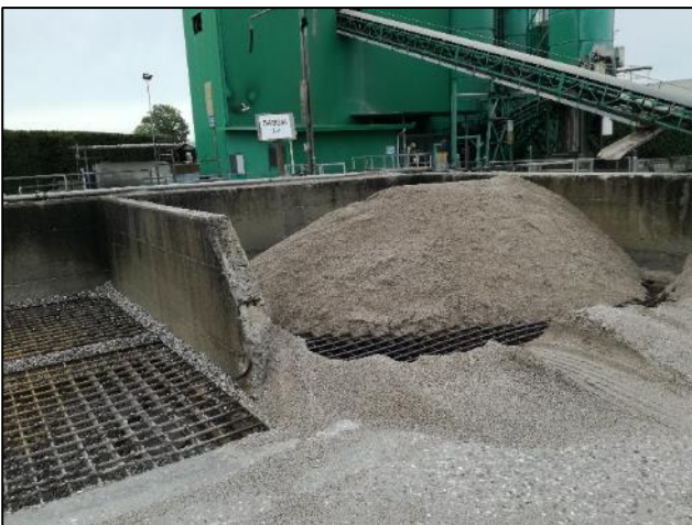
Fig. 5: Rampa carico inerti su tramogge
