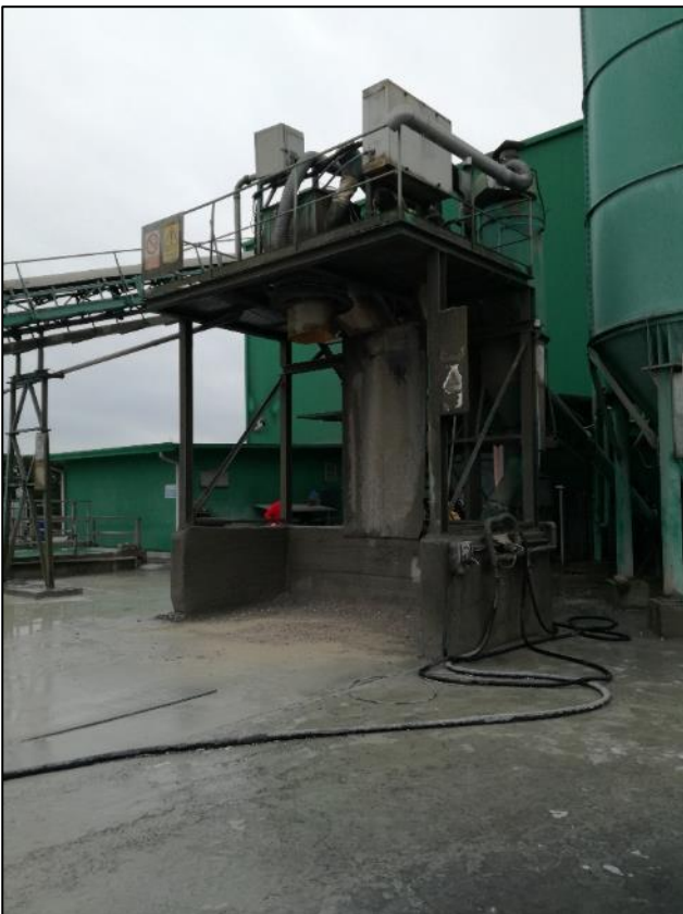
Fig. 9: Bocca di carico mezzo
