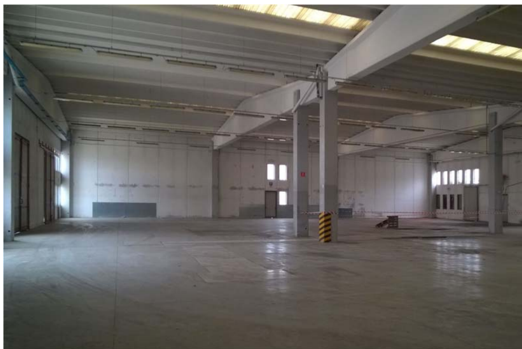
Figura 1.3. Vista interna dell'edificio
