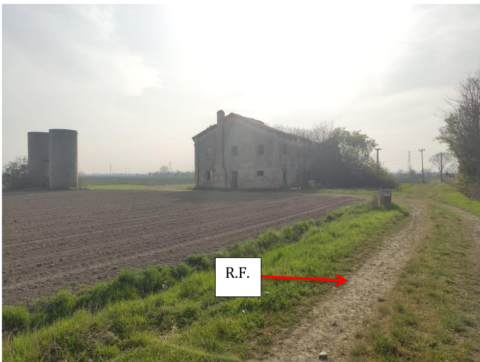
Figura 6 - Foto abitazione disabitata lato Sud stabilimento
