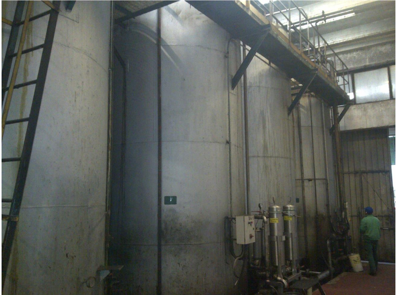
Figura 5 : serbatoi interni stoccaggio grasso animale
