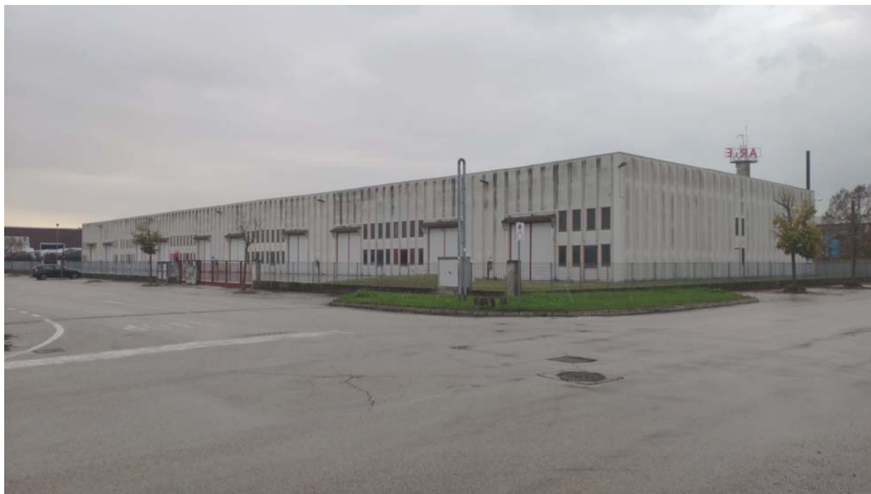
Figura 1.2. Vista del fabbricato industriale da Via delle Industrie II
