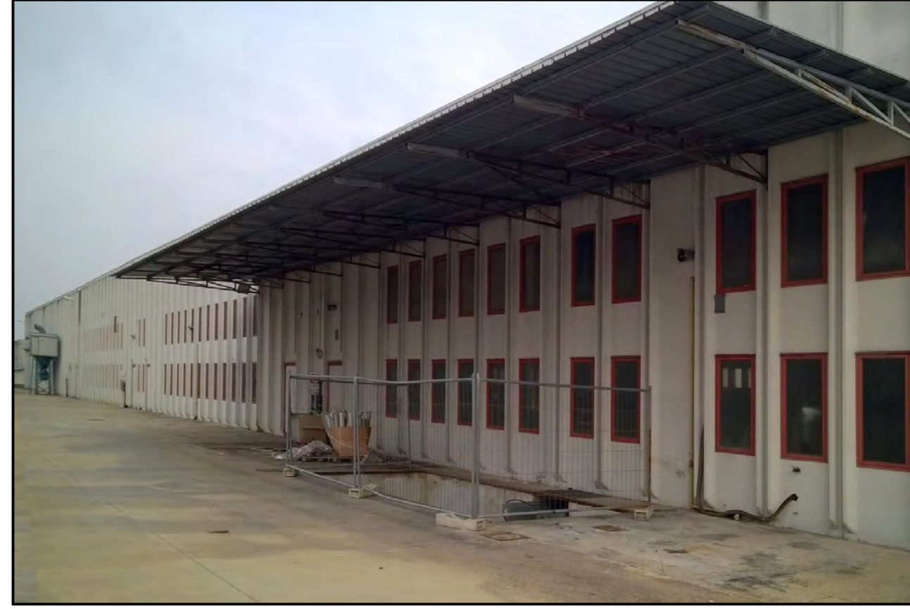
6 VISTA ESTERNA DELL'EDIFICIO PROSPETTO OVEST
