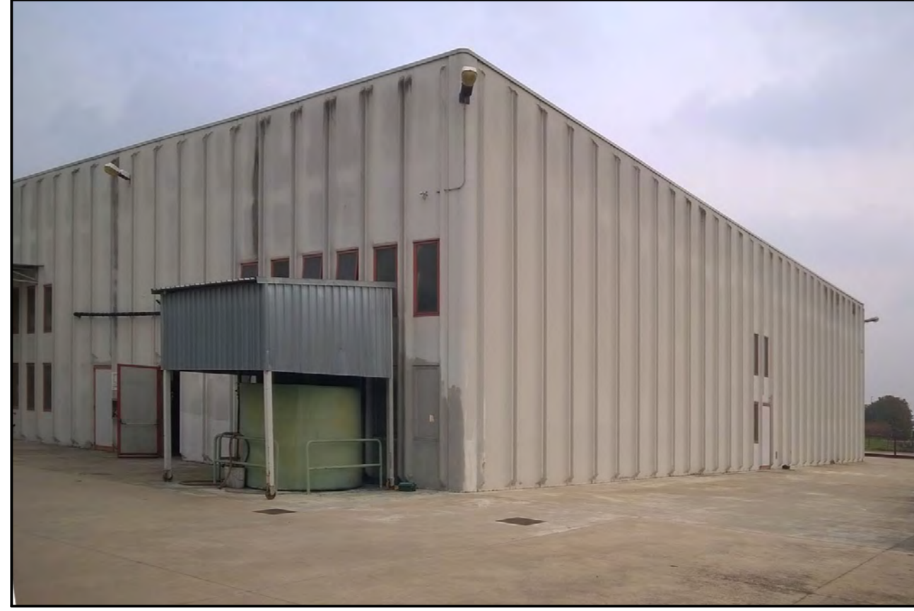
4 VISTA ESTERNA DELL'EDIFICIO PROSPETTO SUD-SUD-OVEST
