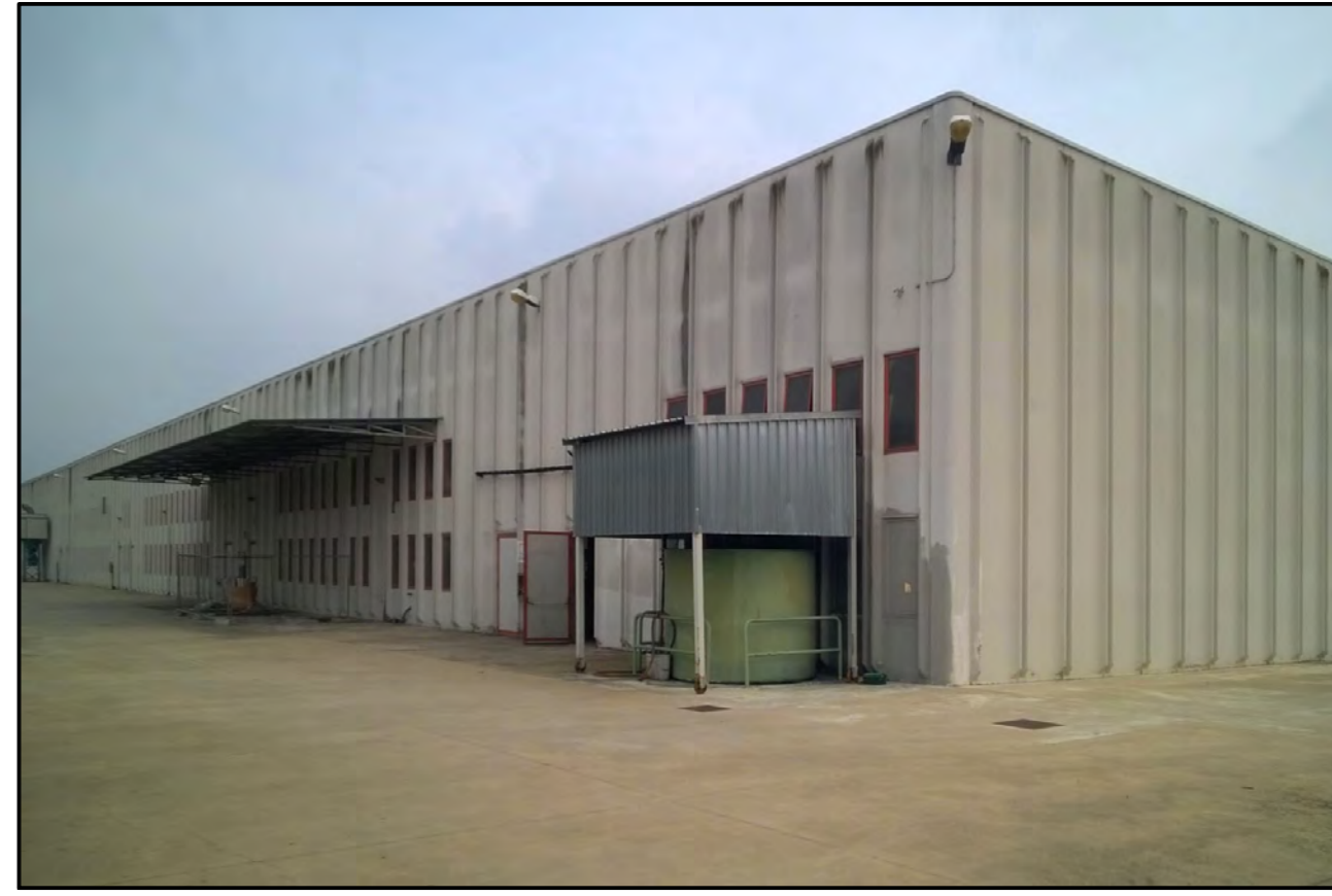
5 VISTA ESTERNA DELL'EDIFICIO PROSPETTO SUD-OVEST
