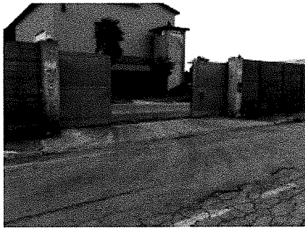
FOTO 1: Vista dell'accesso all'impianto.
