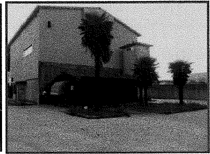
FOTO 3: Vista dei locali uffici e servizi.
