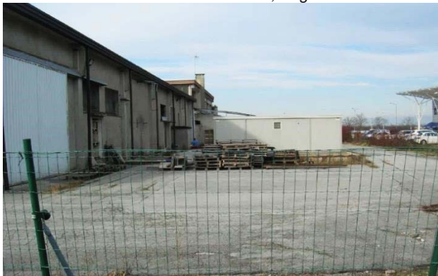
Foto 5: veduta da via Como, da sud-est.
