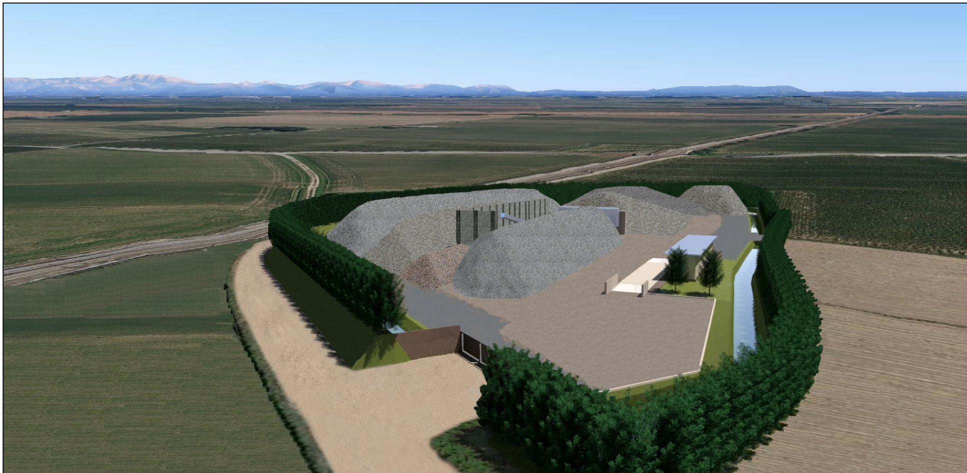
Figura 1 – Rendering dello stabilimento con cumuli innalzati e barriere arboree.
