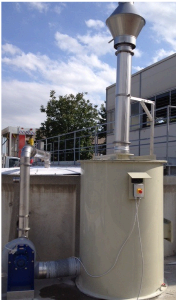
Figura 5. Esempio di sistema di abbattimento a secco
