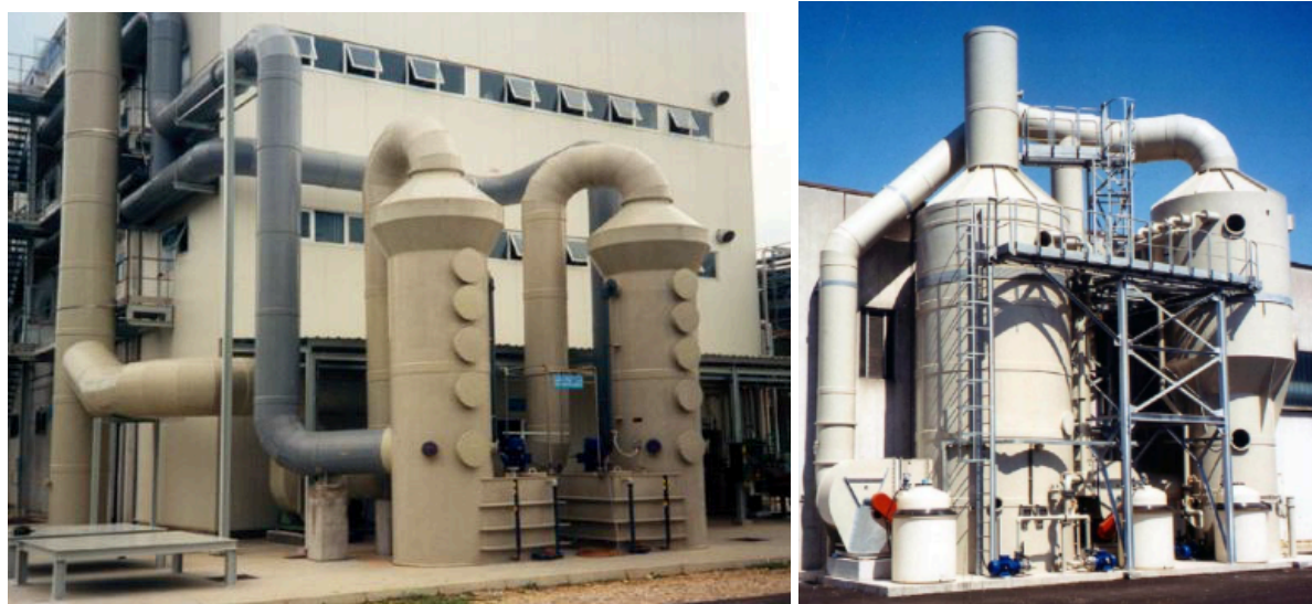
Figura 2. Esempi di impianto di abbattimento a scrubber
