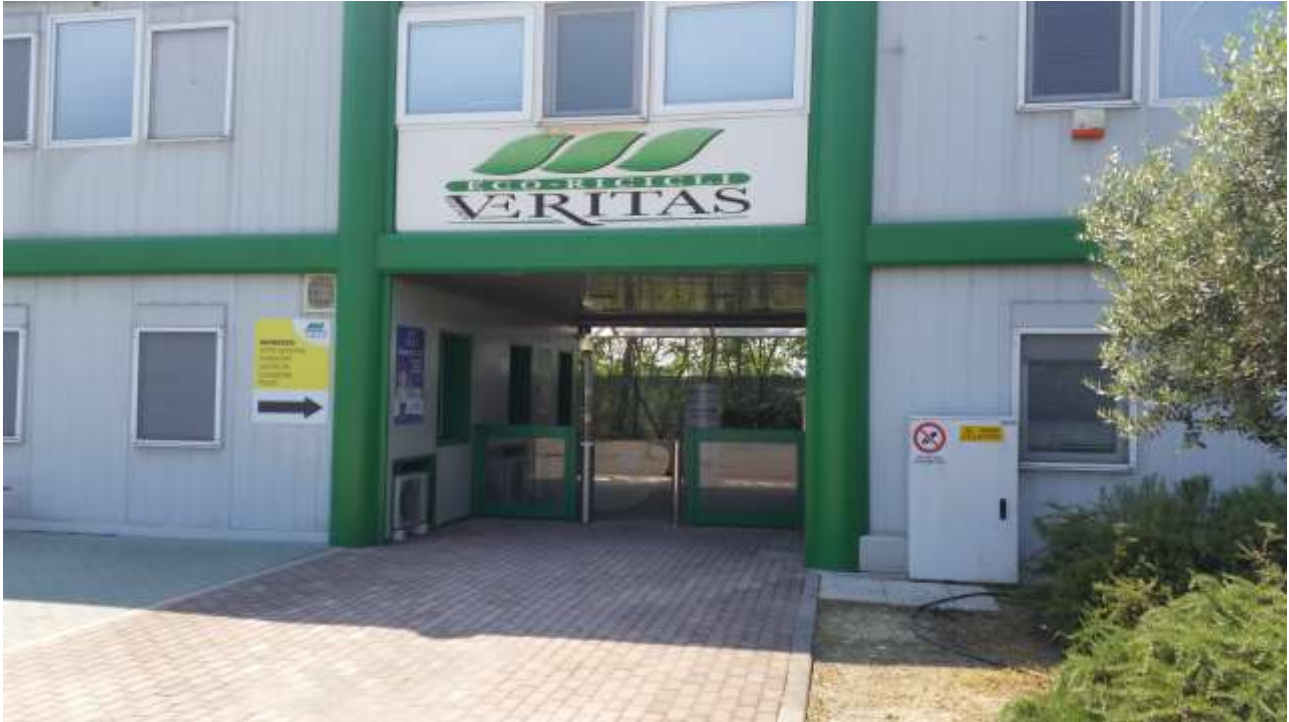
Figura 5-17 – Cono di visuale verso Sud-Est (ingresso palazzina uffici e servizi)
