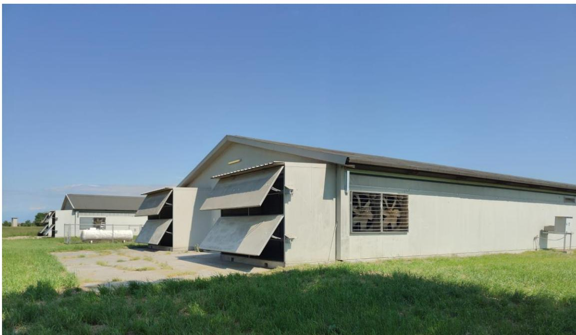
Foto. 1. Visione dei ventilatori sul lato sud con box antipolvere e quelle laterali lato est.
