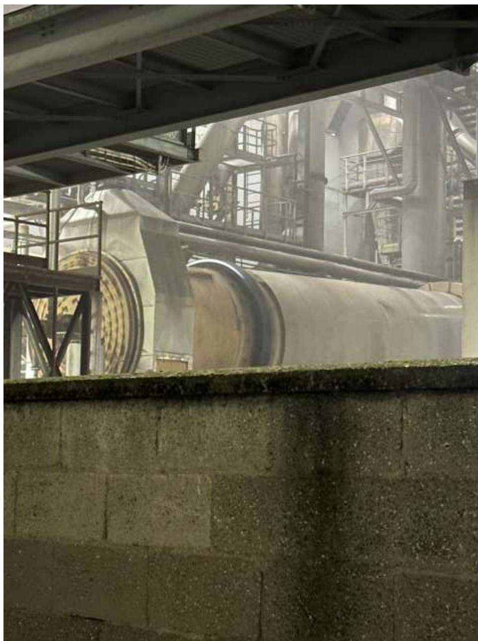
Figura 22: impianti Cereal Docks
