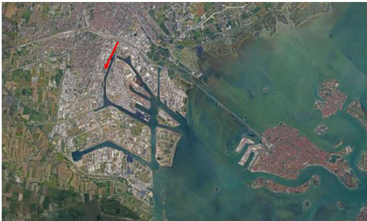
Figura 1: Foto aerea di inquadramento territoriale del sito (fonte: google maps)
