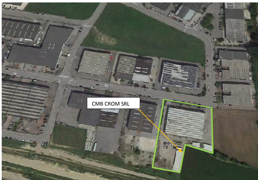
Fig.1: immagine satellitare dell’insediamento produttivo di Via Ferrari 45
