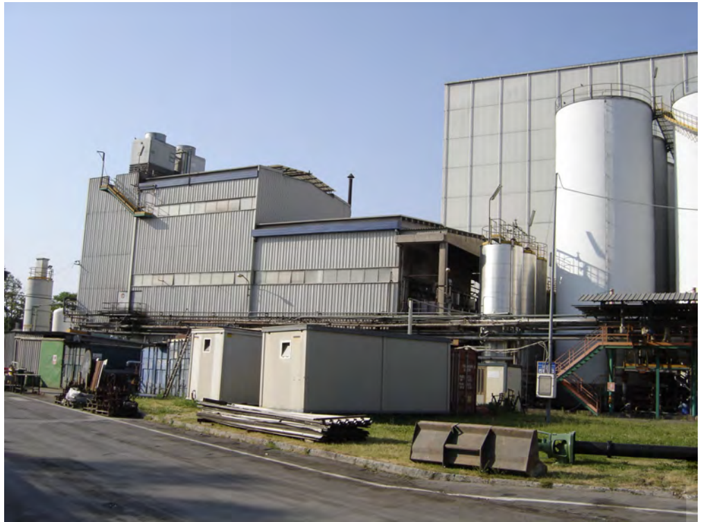
Immagine n. 4: La Raffineria e parte del parco Serbatoi Oli adiacenti attualmente in fase di demolizione (S.C.I.A - PG 2013/0374592, del 30 agosto 2013)
