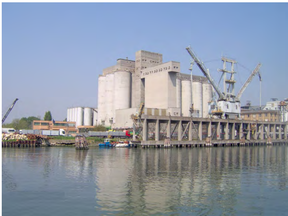
Immagine n. 1: vista dal Canale Industriale Ovest dello Stabilimento Industriale Cereal Docks Marghera S.r.l.
