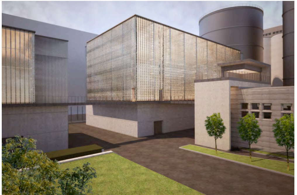
Render 2: vista del nuovo impianto di Preparazione; si può notare l'effetto del rivestimento dato dai pannelli in policarbonato e il basamento in calcestruzzo a vista.
