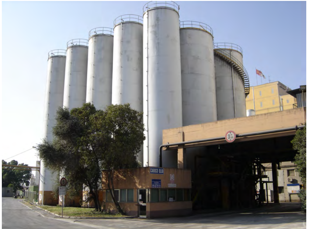
Immagine n. 2: vista dall'interno dello Stabilimento Industriale con i Serbatoi Oli esistenti (non oggetto di intervento)
