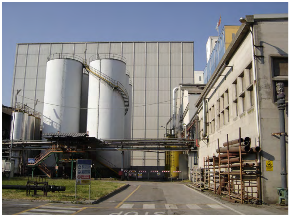
Immagine n. 5: Il Parco Serbatoi Oli attualmente in fase di demolizione (S.C.I.A - PG 2013/0374592, del 30 agosto 2013) collegato all'Impianto di Estrazione che sarà anch'esso demolito assieme all'Officina che si può vedere in primo piano. Sullo sfondo l'edificio di proprietà della ditta Grandi Molini Italiani.
