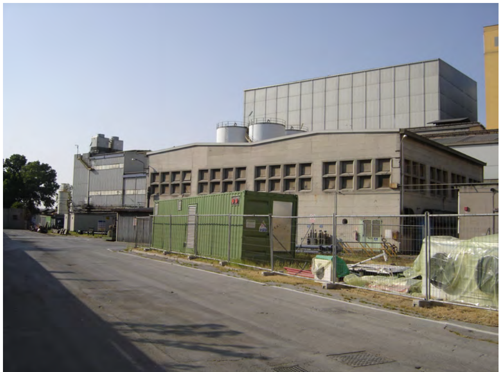
Immagine n. 3: L'attuale Officina Meccanica destinata alla demolizione
