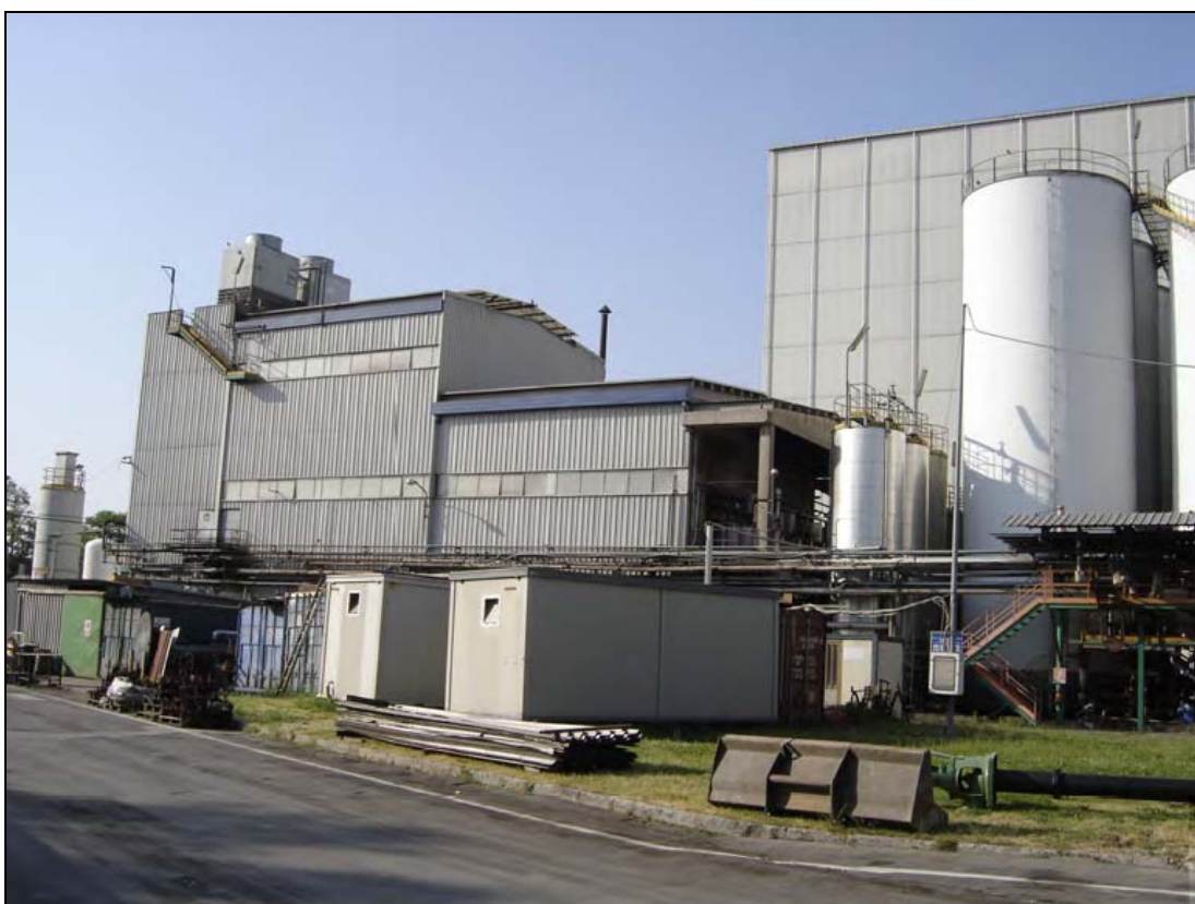
Figura 5.7. Vista del reparto di raffinazione (recentemente dismessa) e del parco serbatoi oli
