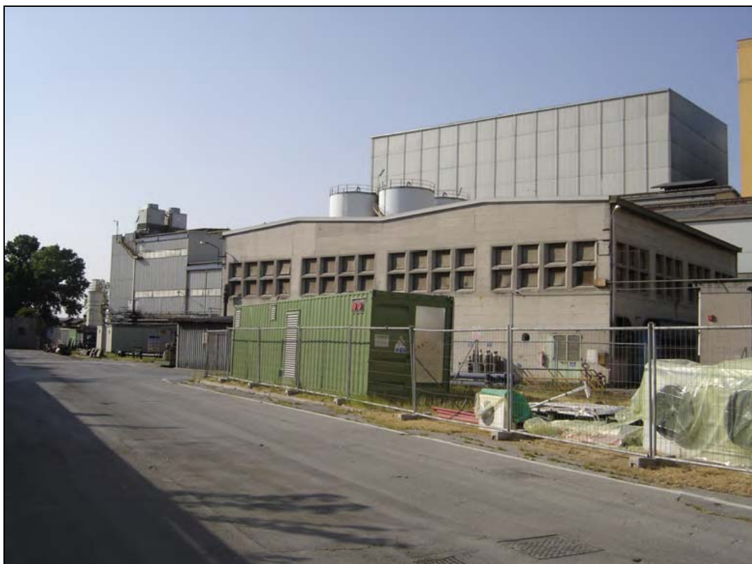
Figura 5.6. Vista dell'attuale officina meccanica – demolizione
