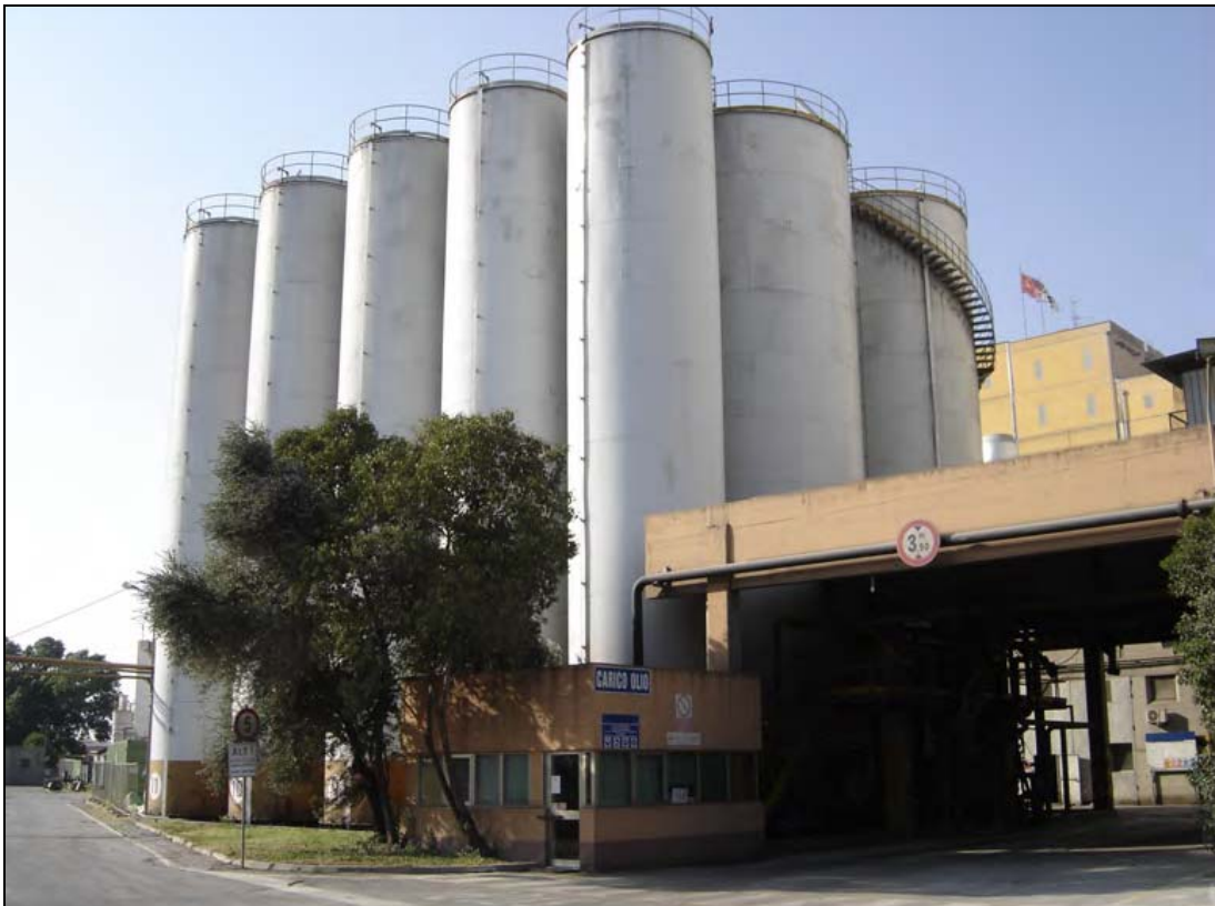
Figura 5.5. Vista dei serbatoi oli esistenti – mantenuti
