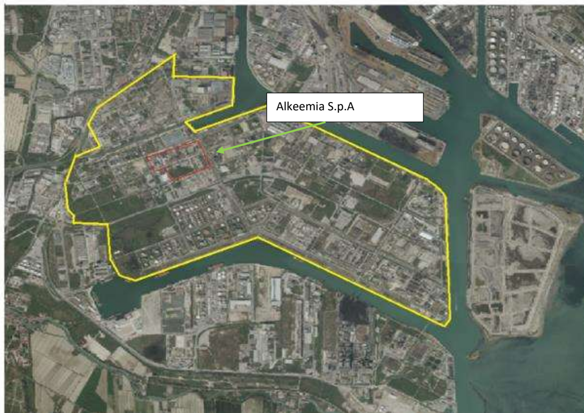
Foto 1: immagine Area industriale di Porto Marghera VE, posizione area Alkeemia
