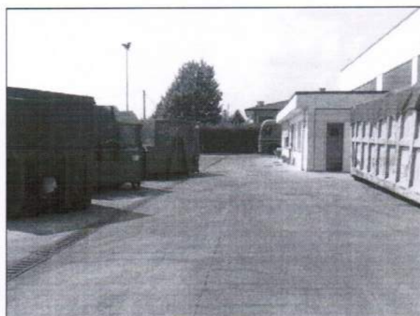
Fig. 2 - area deposito cassoni vuoti
