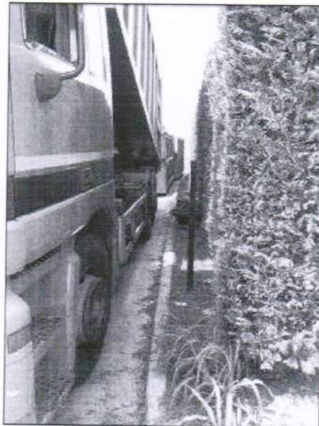
Fig. 29: Cordolo perimetrale di protezione delle aree verdi adiacenti al piazzale
