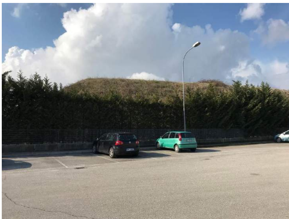
Foto 6 – Vista Est dell'impianto su Via Bugatti
