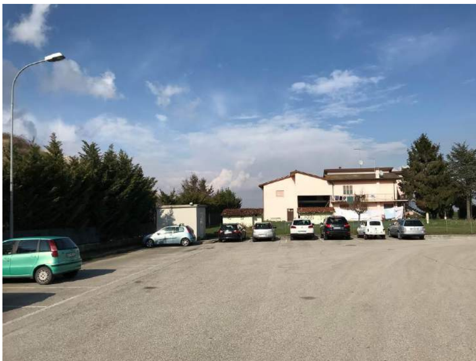
Foto 7 – Vista dell'edificio residenziale a confine dell'impianto
