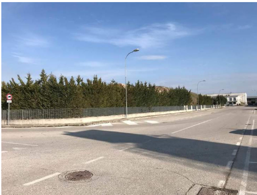
Foto 4 – Vista Sud dell'impianto su Via Bugatti
