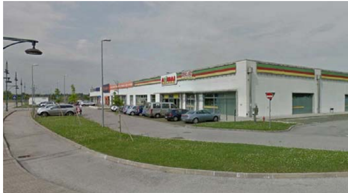
Figura 35 vista dell'edificio da sud
