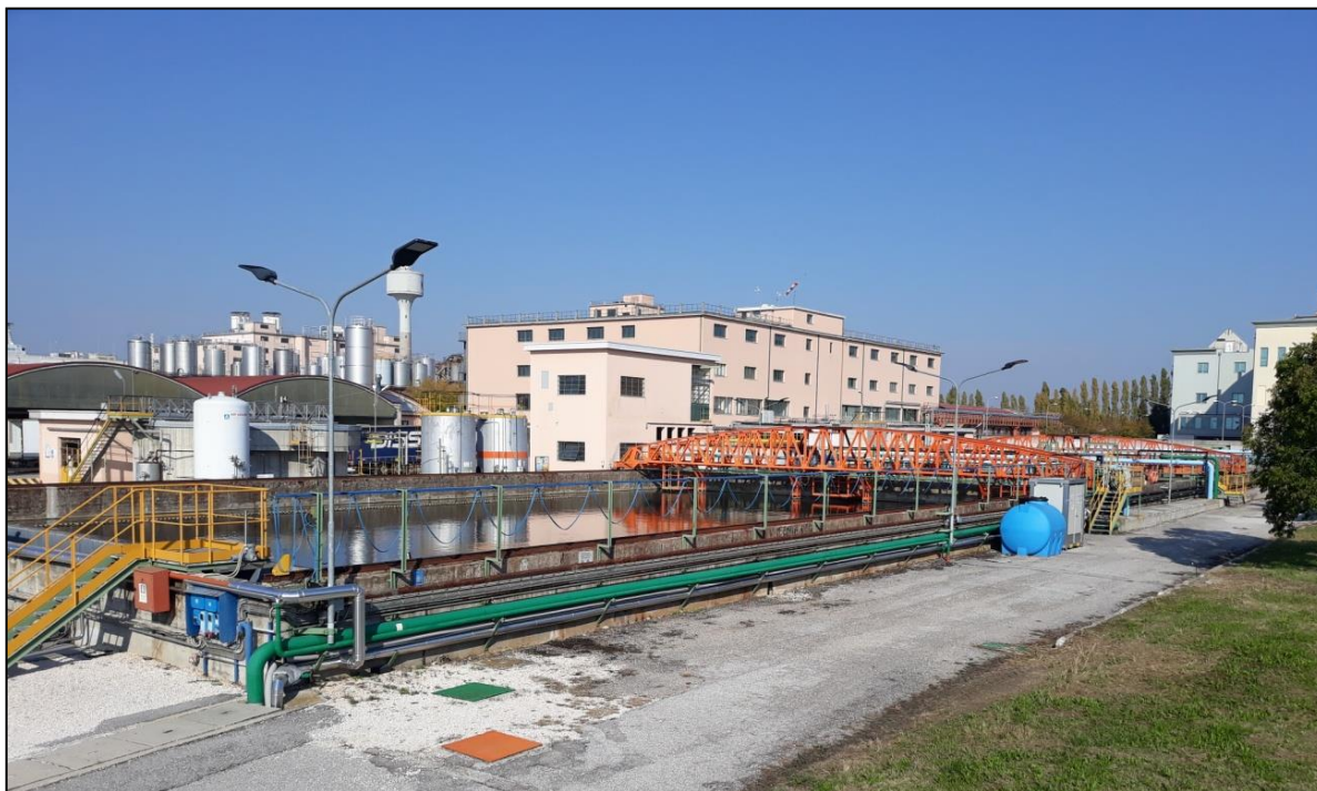
Figura 5 – Impianto di depurazione
